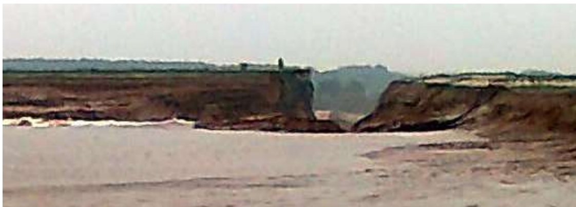
24. ábra. A gépkezelő munkás felvétele az északnyugati sarok átszakadásáról
