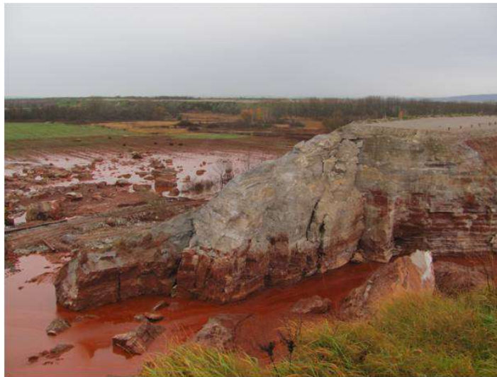
25. ábra. Az északi gát szakadása a katasztrófa után három nappal [Remnants of the north section at 13.10.2010] (Marsi I.)
