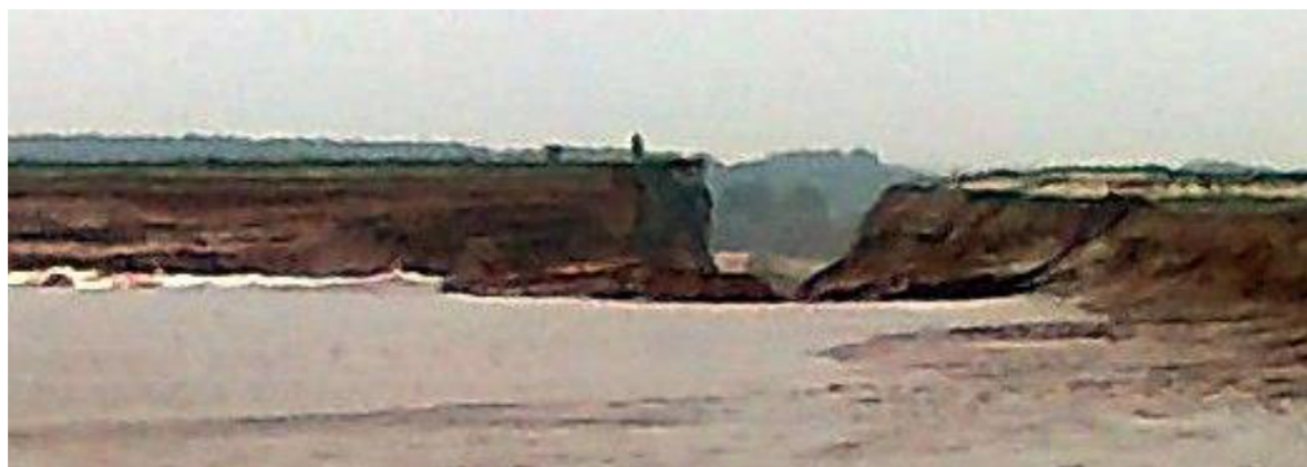
24. ábra. A gépkezelő munkás felvétele az északnyugati sarok átszakadásáról
