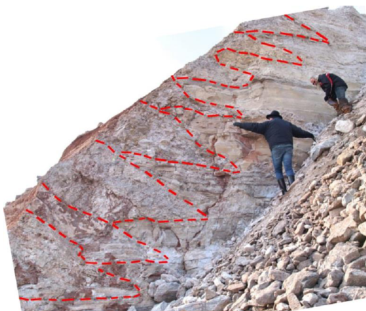
2. ábra. A gát visszabontott nyugati fala az ülepítő medencék körültöltéseinek és kitöltéseinek metszeteivel
