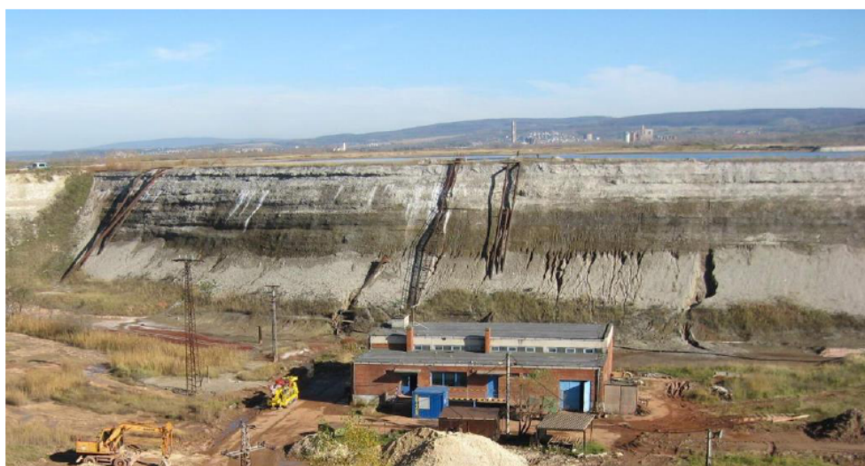
11. ábra. A szivattyúház és mögötte a IX. kazetta fala vastag gátlábi törmelékkúppal
