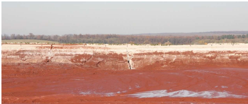
27. ábra. A vörösiszap nedvességtartalmának másodlagos megcsapolása [Secondary tapping of the caustic liquor] (Jordán Gy., 2010. nov. 5.)
