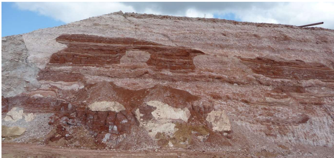
13. ábra. A vízzáró kéreg (fehér) maradványai a lemosott északi falon [Remnants of the (white) waterproof crust on the washed inner surface of reservoir No 10] (Fügedi U., 2011. ápr. 13.)
