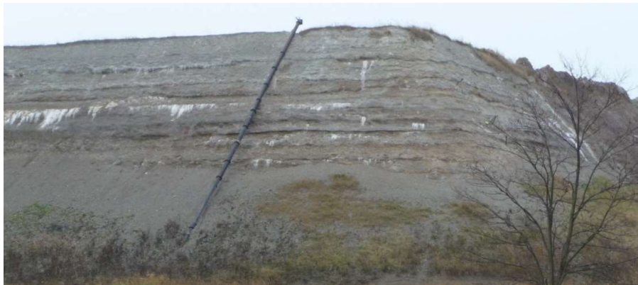
12. ábra. A IX. kazetta délnyugati sarka a gáttestből kipreparálódó homokcsíkokkal [Well-prepared sandy layers in the embankment of Reservoir No 9 at its south-western corner] (Fügedi U., 2010. nov. 10.)
