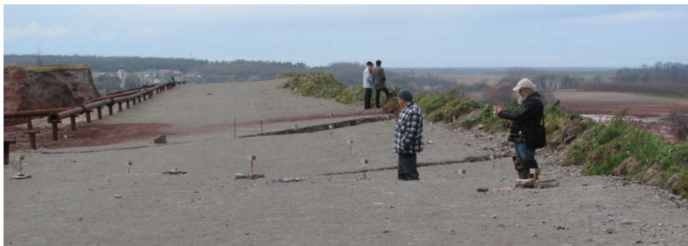
26. ábra. A virágszerkezetű törés az északi fal közepén a gát kimozdult és megsüllyedt szakaszával [The flower structure system with the tipped-out and sunken-in section of the embankment] (Marsi I., 2010. nov. 10.)
