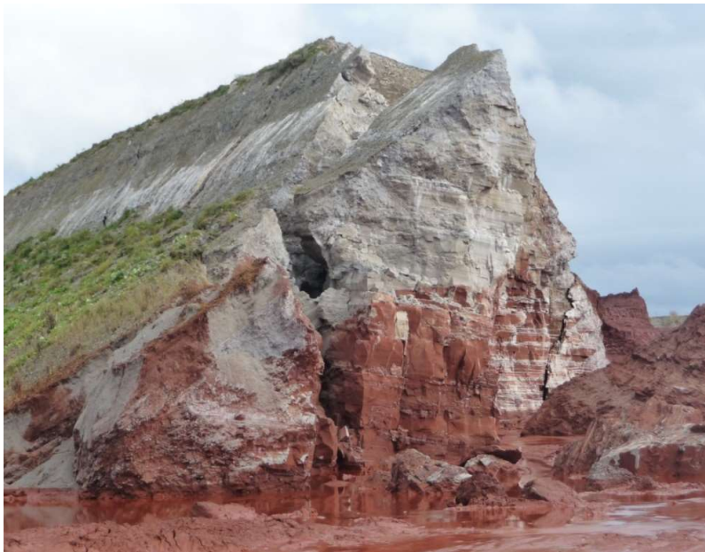
5. ábra. Fehér homokcsíkok a kazetta átszakadt északi falán [White sandy layers on the western wall of the northern embankment] (Fügedi U., 2010. nov. 10.)
