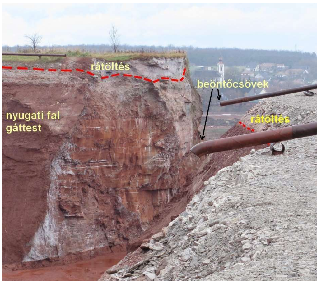
6. ábra: A beöntőcsövek és a 2010 nyarán elvégzett szintkiegyenlítő feltöltés
